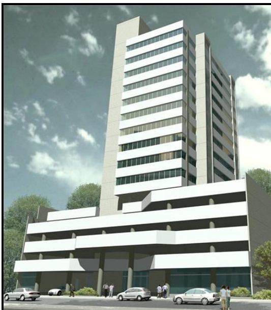
Figura 2 – Fachada Edifício Comercial.
