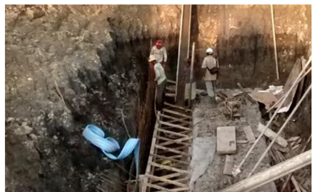
Gambar 14. Internal Vibrator pada pekerjaan pondasi penahan dinding
