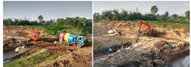
Gambar 13. Penuangan beton menggunakan excavator
