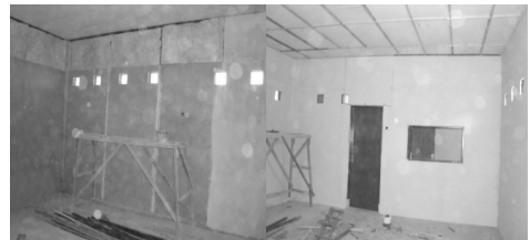
Gambar 6. Pemasang panel MDF dinding ruang musik
