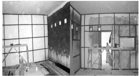
Gambar 5. Pemasang rangka pada dinding ruang musik
