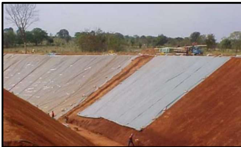
Figura 3: Instalação de geotêxtil em taludes.
