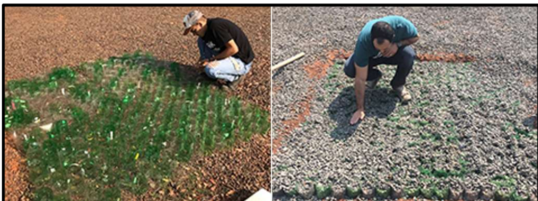
Figura 30: Geocélulas de PET aplicadas em um estacionamento
