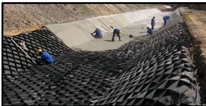
Figura 10: Uso da geocélula em revestimento de canais
