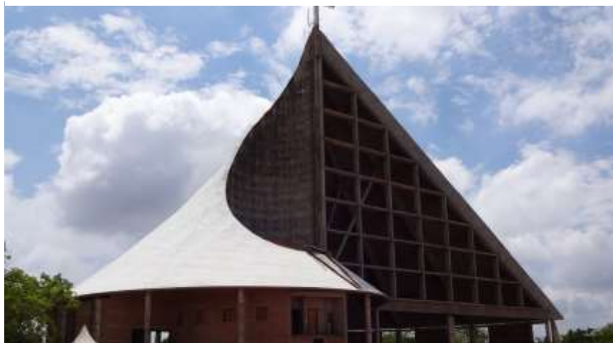
Figura 25: Igreja do Bom Jesus em construção - 2018
