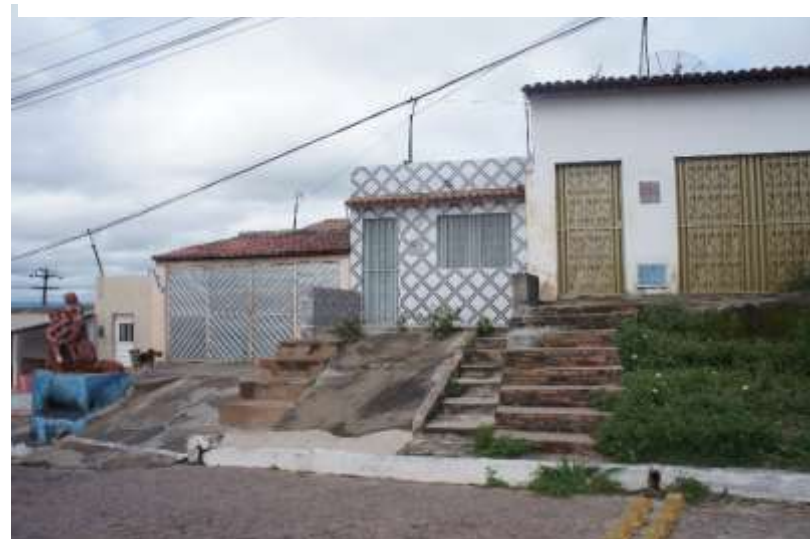
Figura 39: Calçadas desniveladas na subida do horto
