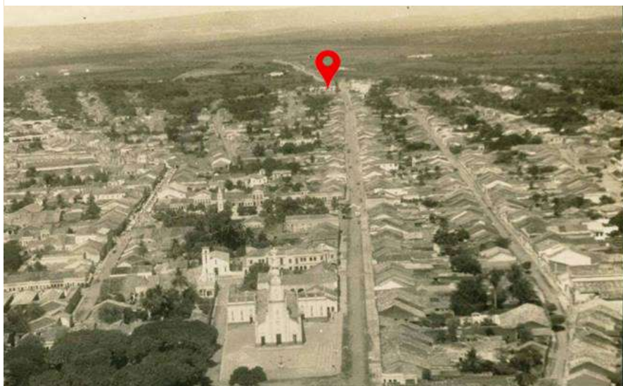
Figura 41: Vista aérea Juazeiro década de 50
