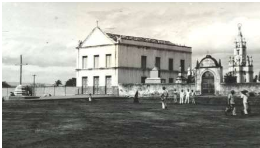
Figura17: Capela do Socorro década de 30 ou 40
