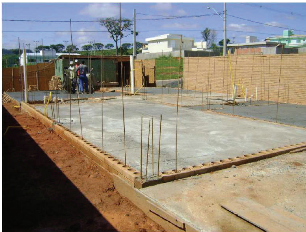
Figura 9 – Ferro de espera posicionados e fiada guia executada
