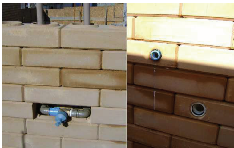
Figura 11 – Instalação de hidráulica em alvenaria de BTC
