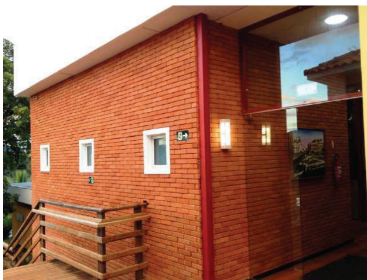
Figura 12 – Alvenaria finalizada com blocos aparentes.
