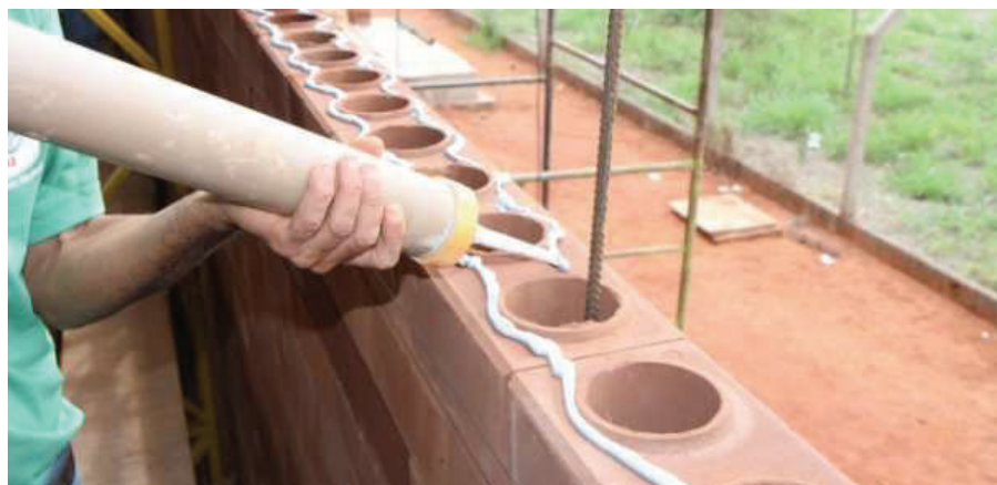
Figura 10 – Aplicação de argamassa fluida utilizando a bisnaga.
