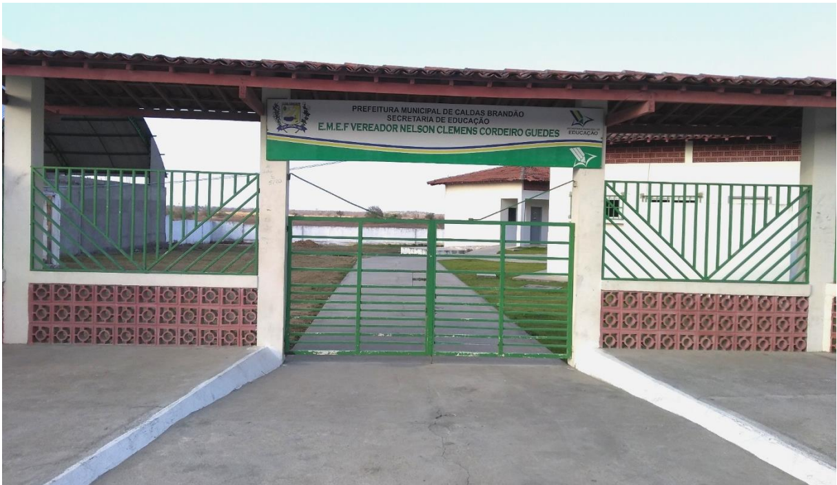
Figura 3 – Fachada da Escola Nelson Clemens Cordeiro Guedes
