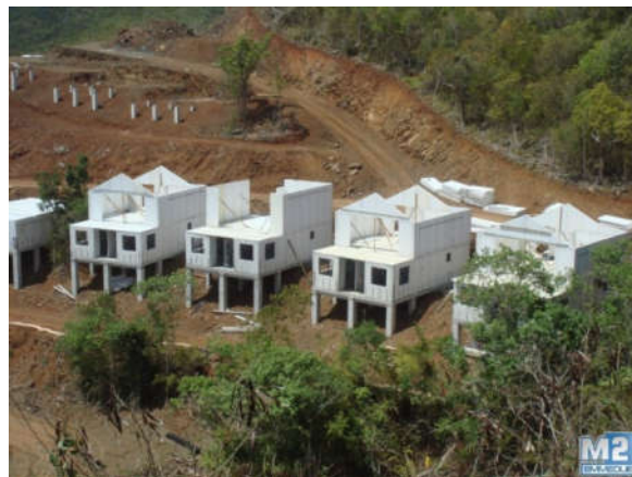
Figura 4 - Casas de turismo construídas com painéis sanduíche em base de concreto armado
