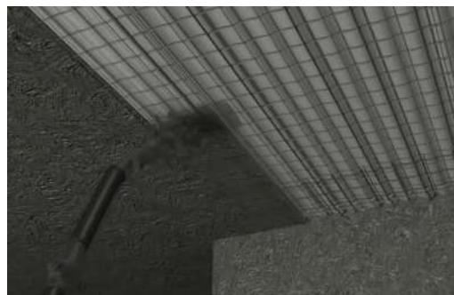
Figura 21 - Projeção de argamassa estrutural nas lajes
