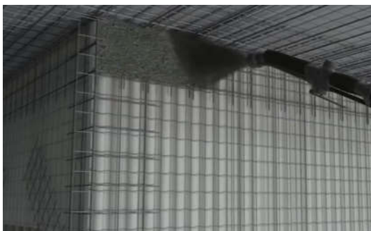
Figura 20 - Projeção de argamassa estrutural nas paredes
