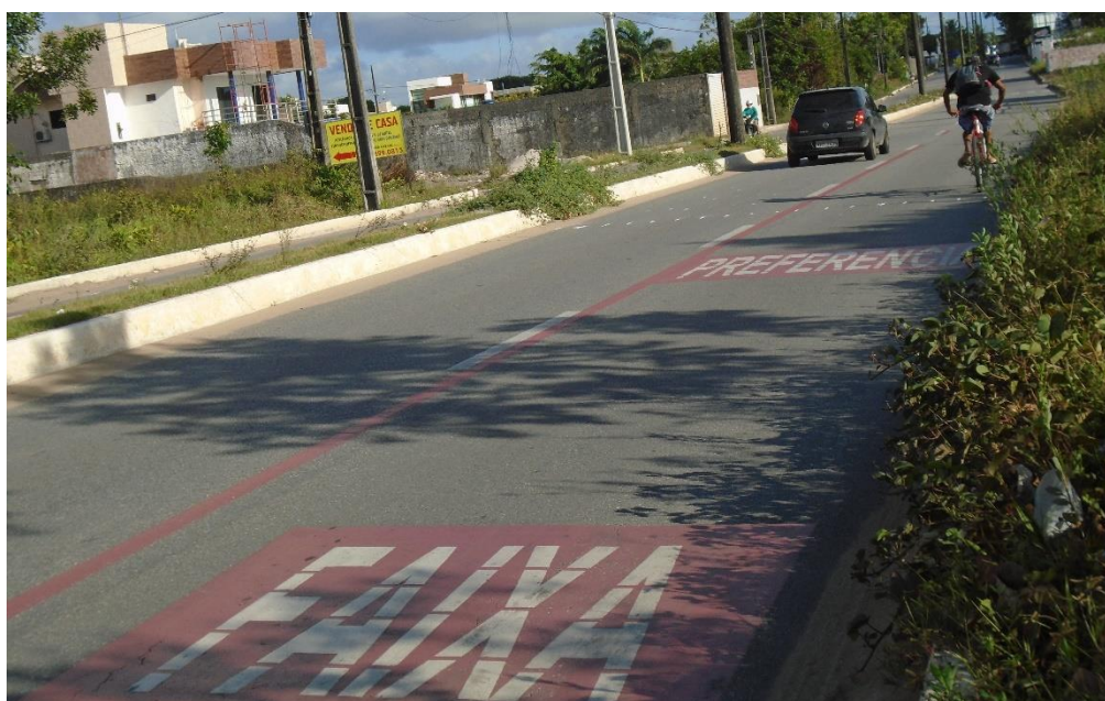
Figura 12 – Vegetação invadindo a pista na Av. Gov. Antônio Mariz da Silva em 2017
