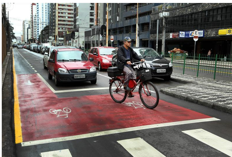
Figura 6 – Estrutura conhecida como “bicaixa” na cidade de Curitiba-PR
