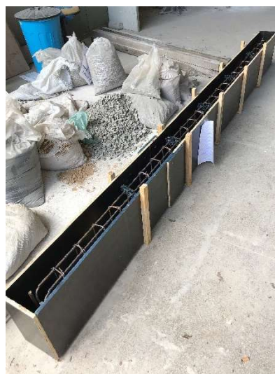
Figura 13 - Fôrma da viga com dimensões de 0,14m x 0,30m x 3,20m.
