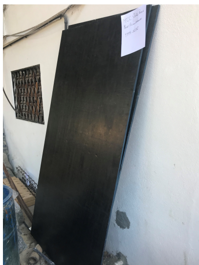
Figura 12 - Madeirite plastificado utilizado para fabricação da fôrma da viga.
