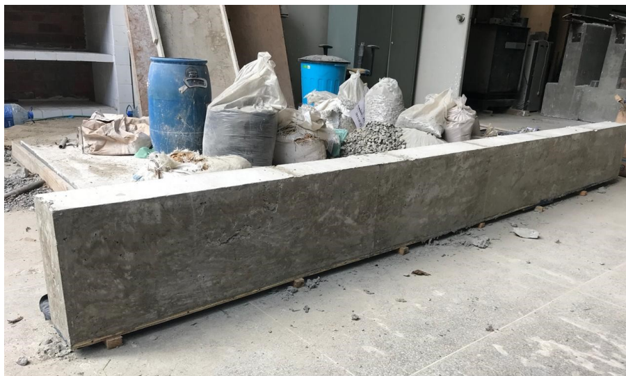
Figura 19 - Viga após retirada das fôrmas.
