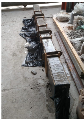
Figura 18 - Viga com superfície molhada durante o processo de cura.
