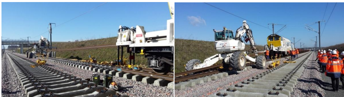
Figura 20 - Colocação dos trilhos com o Wagon-Pousseur.
