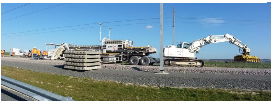
Figura 19 - Colocação das dormentes na plataforma.
