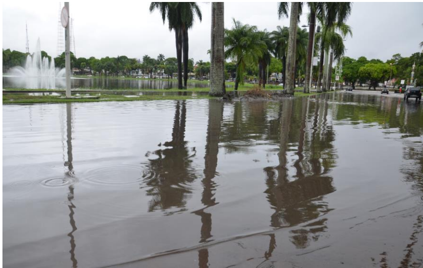
Figura 13. Problemas urbanos no Parque Sólon de Lucena antes do projeto de requalificação. Lagoa alagada em período de chuva, 2013. Fonte: Walter Papparazzo, Site: G1.
