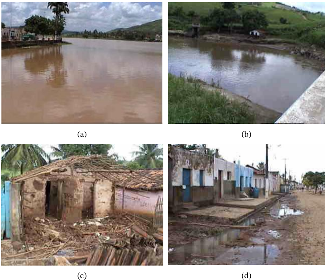
Figura 5.4 – Fotos da área urbana do município de Alagoa Grande em janeiro/fevereiro de 2004. (a) Lagoa no centro do município. (b) Ponte sobre o rio Mamanguape – Jusante. (c) Casa destruída pelas chuvas – Canafístula. (d) Rua que ficou completamente alagada (FONTE: AAGISA, 2004).
