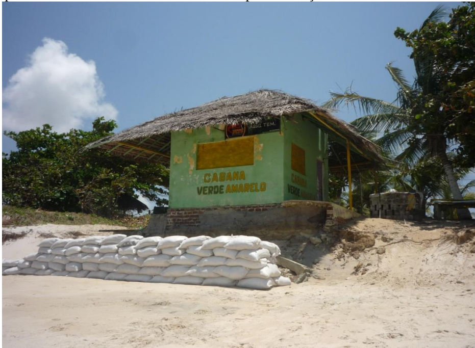
Figura 1: Barraca na praia de Jacumã, fechada em pleno domingo de verão. Detalhe para os sacos de areia usados como barreira para o avanço do mar.
