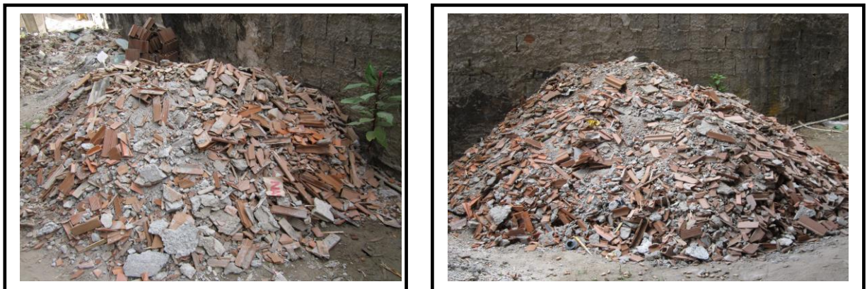
Figura 3.2: RCC classe A, geração e segregação
