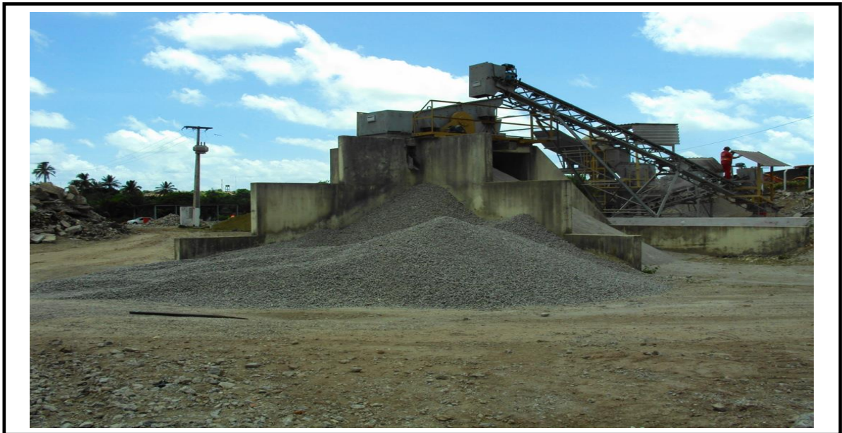
Figura 2.15: Separação em baias (interior da USIBEN) Fonte: Autor da pesquisa. (jun/2009).
