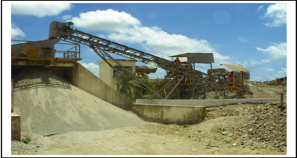
Figura 2.16: Esteira transportadora (interior da USIBEN) Fonte: Autor da pesquisa. (jun/2009).
