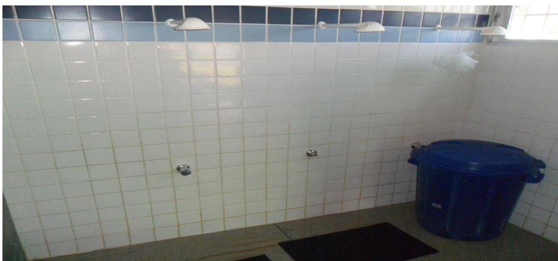
Foto 11 – Área de banho do banheiro.
