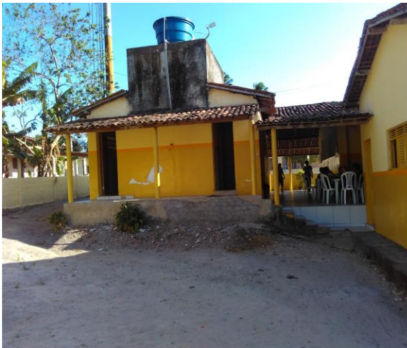
FOTO DOS BANHEIROS DA ESCOLA NILO PEÇANHA
