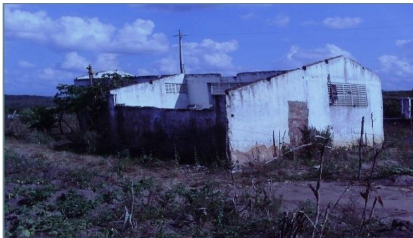
Figura 1: Galpão em ruínas onde funcionou a Escola Tiradentes, no período inicial do acampamento.
