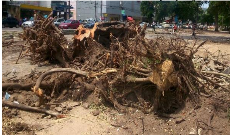
Figura 15 – Raízes e troncos de árvores derrubadas para passagem do BRT
