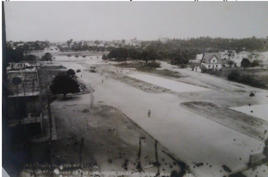
Figura 4 - Início das obras da Parkway: Av. Getúlio Vargas e Lagoa, ao fundo
