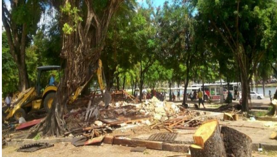
Figura 14 – Retirada dos entulhos e troncos de árvores jovens
