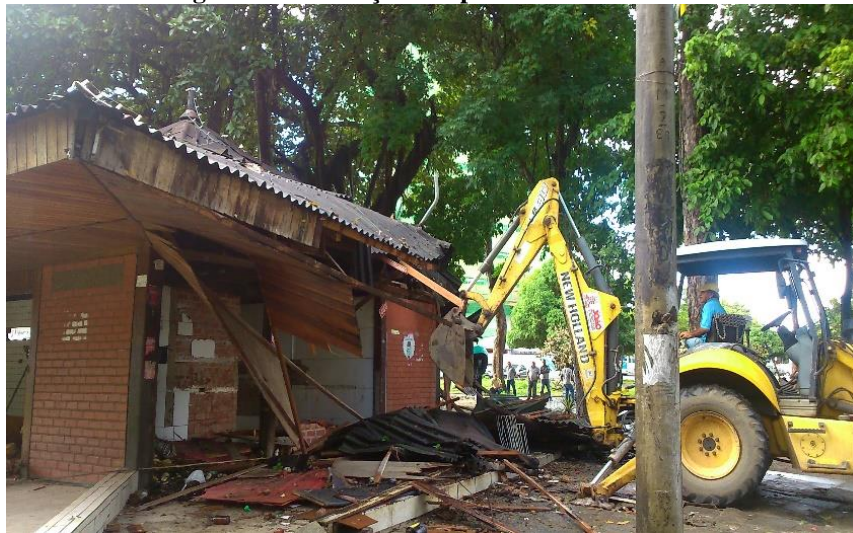
Figura 5 - Demolição das primeiras barracas
