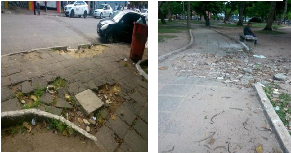
Figura 12 – Calçadas do Parque Sólon de Lucena quebrada em várias partes
