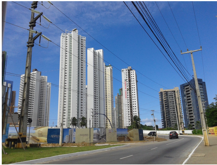
Figura 4- Vista da entrada de acesso ao bairro do Altiplano Cabo Branco
