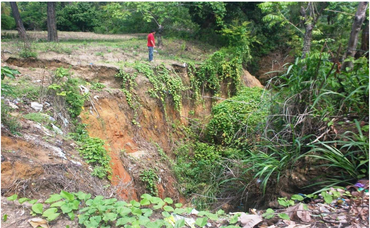
Foto 7 – Voçoroca formada na área urbana do Distrito de Livramento. Ela se estabelece bem próximo a varias residências, e por estar em estagio de evolução, representa sério risco para a população que reside em seus arredores. Fonte: avervo do autor. Data 05/06/2013.
