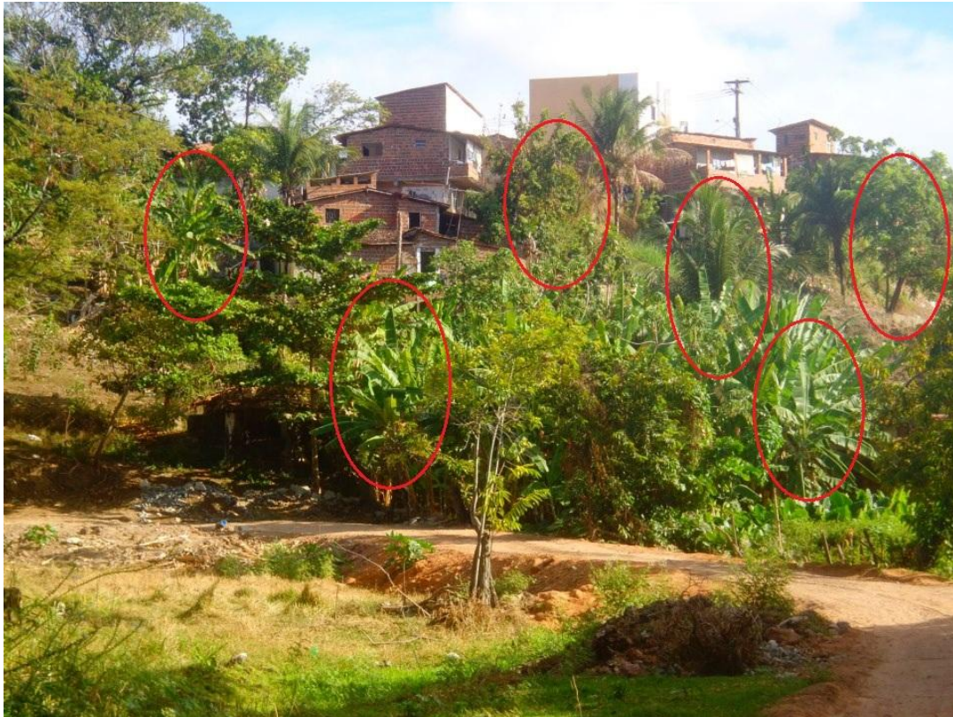
Foto 3 Bananeiras e árvores de grande porte ocupando os taludes. Fonte: GARCIA 23-03-2013
