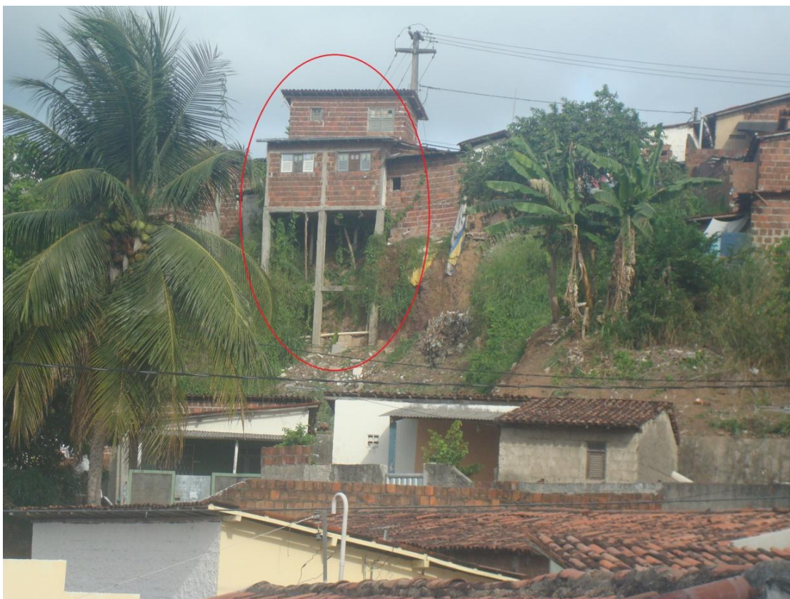
Foto 30 Residência com risco estrutural. Fonte: GARCIA 07-03-2013
