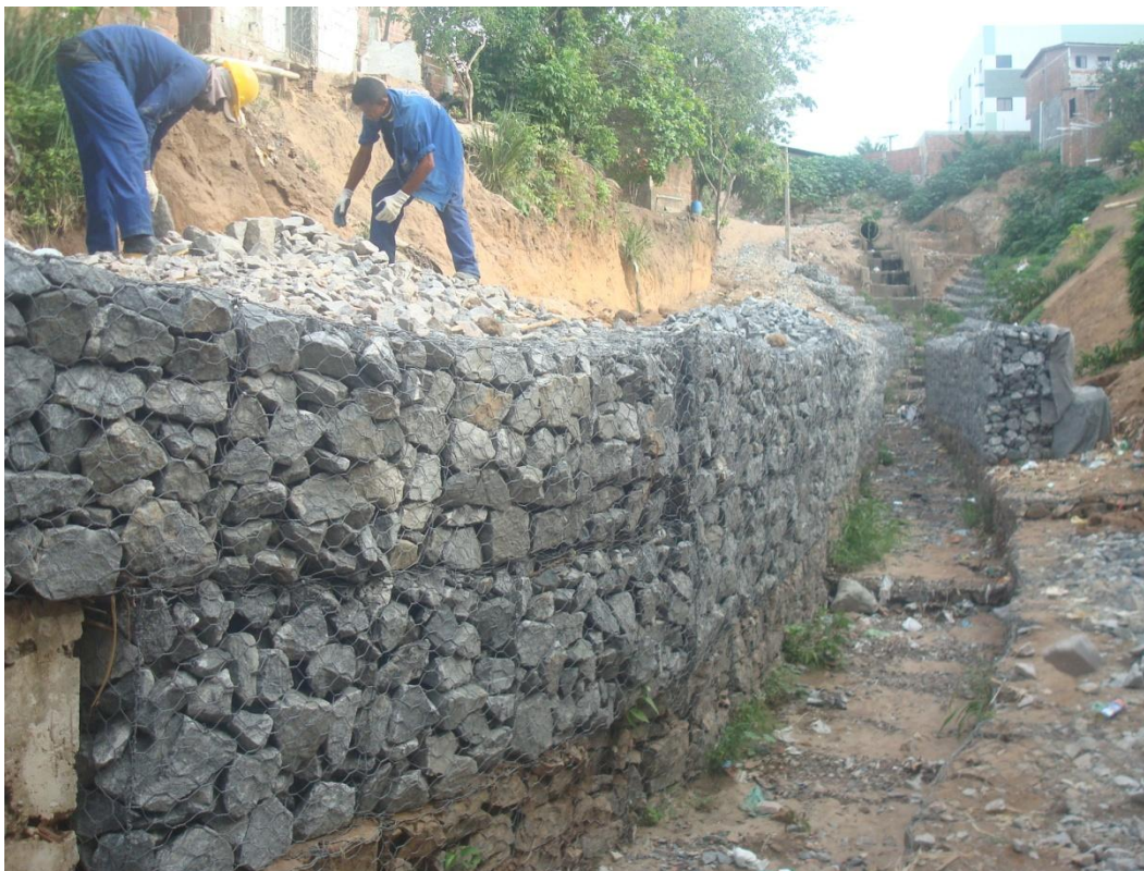
Foto 5 Construção de gabiões de granito e drenagem pluvial, com o intuito de estabilizar os taludes. Fonte: GARCIA 07-03-2013
