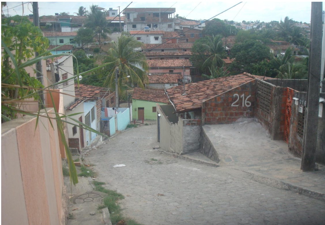
Foto 1 - Vista parcial de uma das entradas da Comunidade Santa Clara no bairro do Castelo Branco em João Pessoa-PB, Fonte: GARCIA 07-03-2013.
