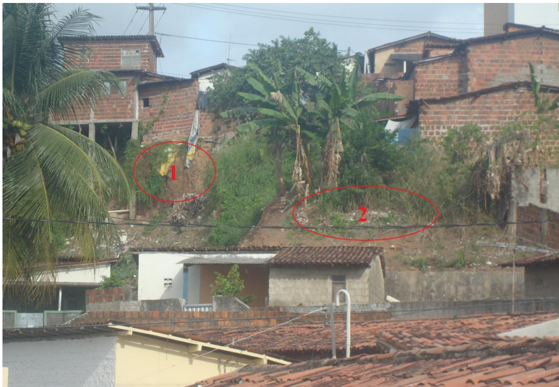
Foto 2 Talude de corte e talude de aterro. Fonte: GARCIA 07-03-2013
