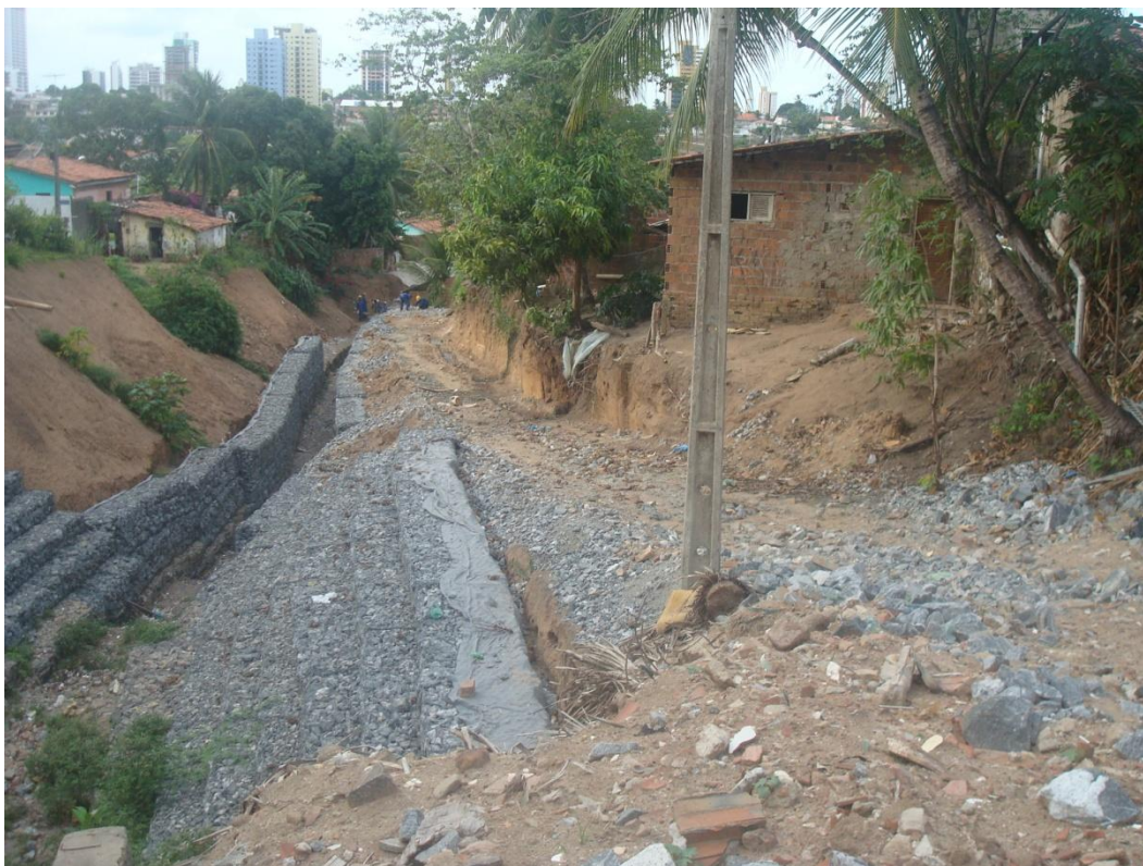
Foto 6 Obras de estabilização de taludes e drenagem pluvial com uso de gabiões de granito. Fonte: GARCIA 07-03-2013
