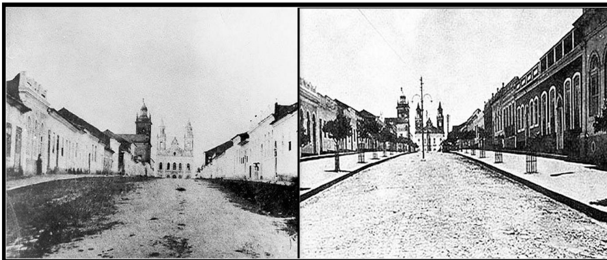
Foto 1: Avenida General Osório 5
