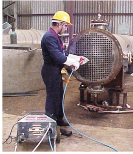
Gambar 1. Proses Pemuangan sisa pipa pada tubesheet (sumber: www.powermaster.in)
