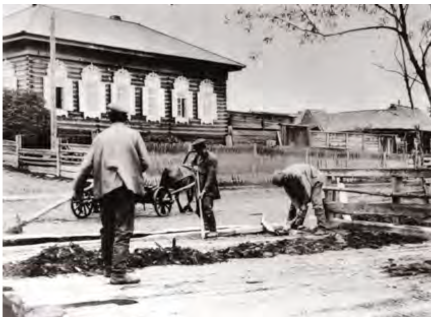
< Скопцы за ремонтом мостовой в Олекминске. С фото Е. П. Ерескьо
