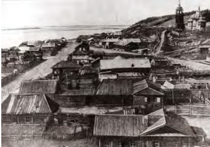
^ Фрагмент деревянной застройки Олекминска
