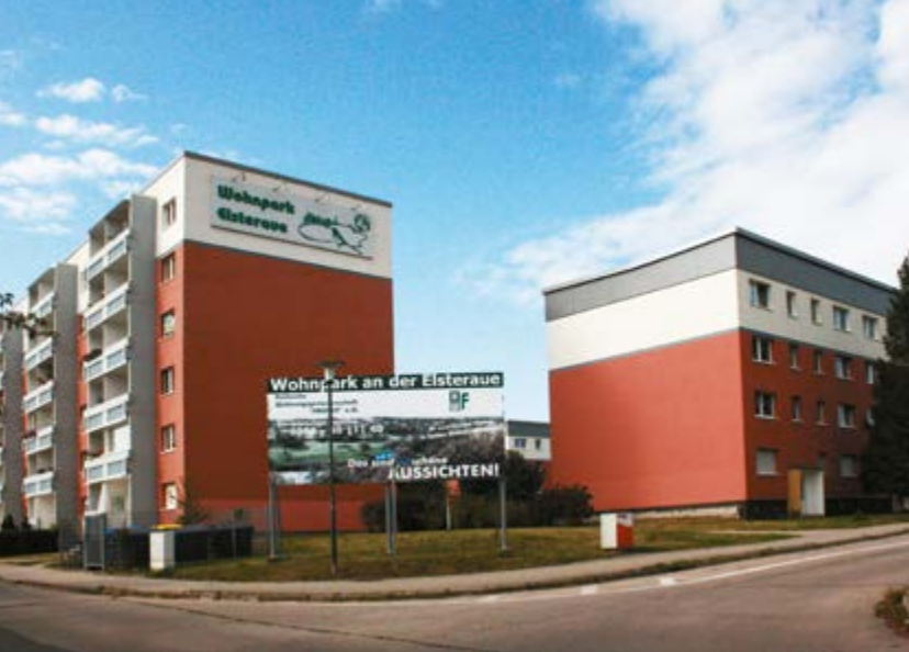
^ Рис. 5. Зильберхёэ. Реконструкция крупнопанельной застройки с применением современных материалов. Фото А. Малько, 2016
