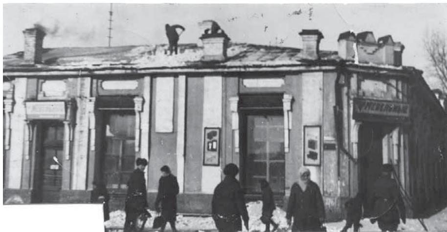
v Торговый лабаз XIX века на углу ул. Дзержинского и Чехова, перестроенный в 4-этажный жилой дом
