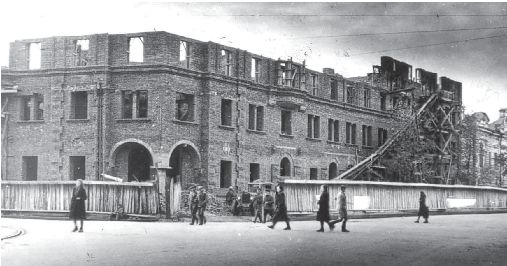
v Строительство жилого дома по ул. Ленина, 24, 1947 г.
