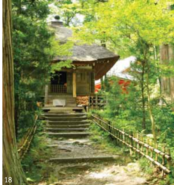
^ Рис. 18. Пример низкого забора, ограничивающего дорожку к храму (префектура Ямагата). Эта конструкция сделана из бамбуковых стоек, вкопанных в землю на равных интервалах и держащих два длинных горизонтально расположенных бамбуковых стебля, прикрепленных при помощи лианы / Example of a low fence delimiting the access path to a temple (Yamagata prefecture). This “gaki” is composed of bamboo stakes sunk into the ground at regular intervals holding two long horizontal bamboo branches on which are attached with liana the crossbars
