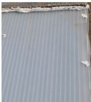
Figura 5-12 – Frestas vedadas com Silicone.
