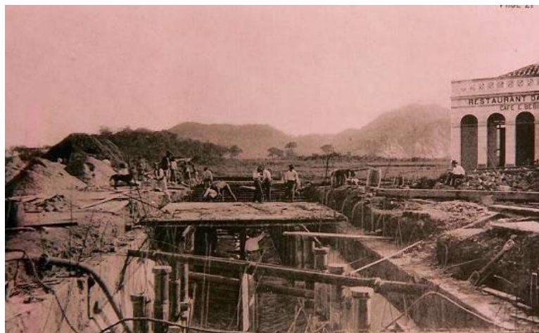
Figura 25 – Foto do início das obras do canal 1, em Santos (início do século XX).
