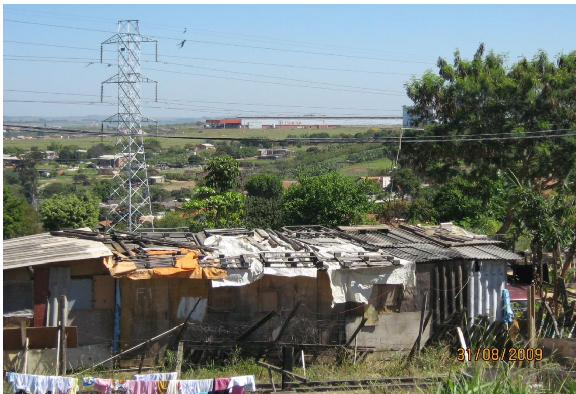
FIGURA 27 - EDIFICAÇÕES EM SITUAÇÃO DE RISCO
