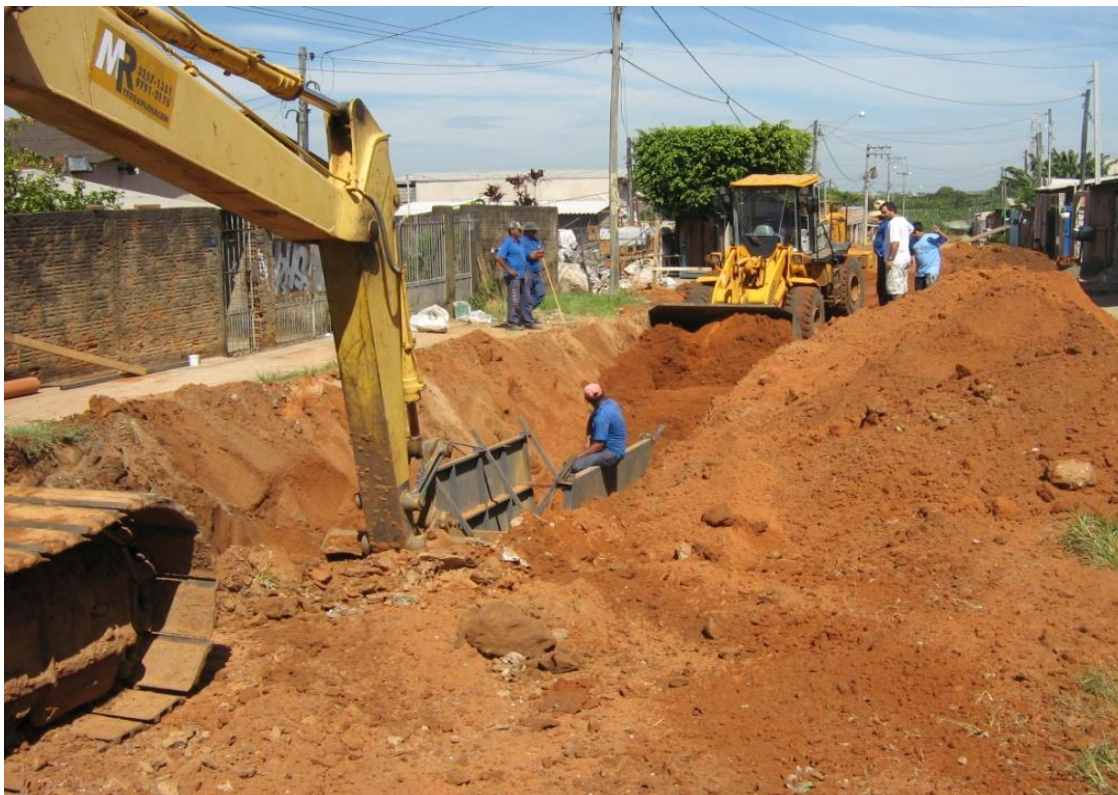
FIGURA 39 – EXECUÇÃO DE REDE DE ESGOTO
