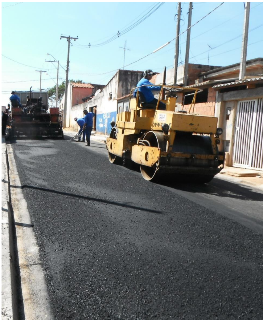
FIGURA 42- OBRAS PARA PAVIMENTAÇÃO
