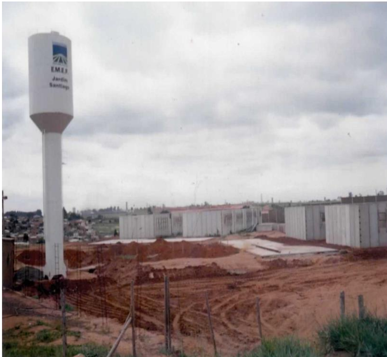
FIGURA 16 - CONSTRUÇÃO DA ESCOLA MUNICIPAL “JARDIM SANTIAGO”
