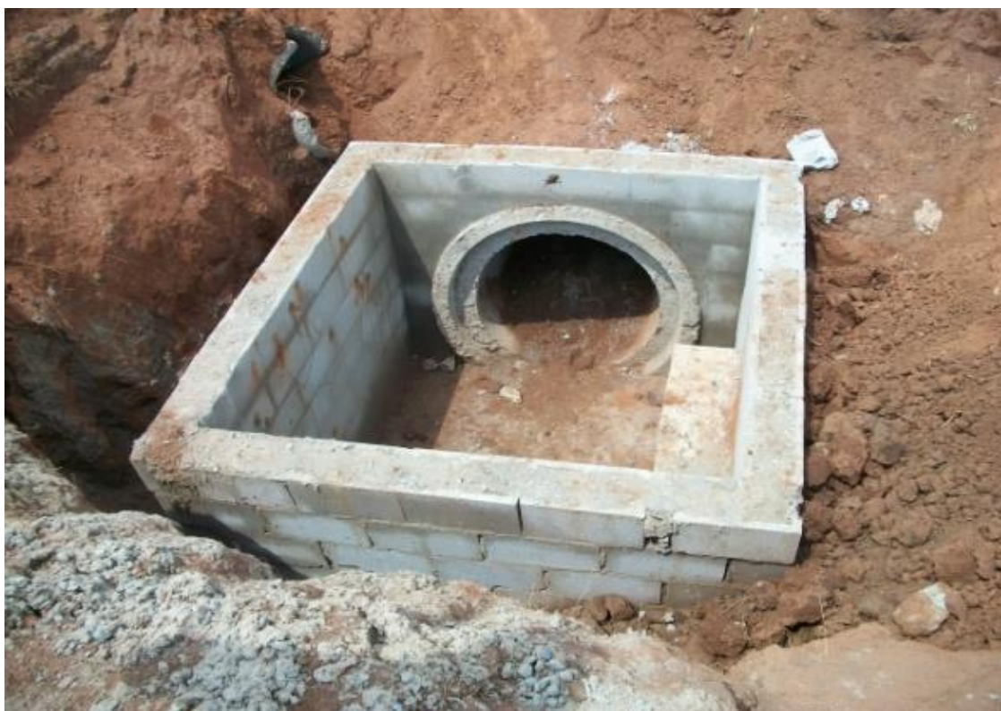
FIGURA 40- EXECUÇÃO DE REDE DE ESGOTO
