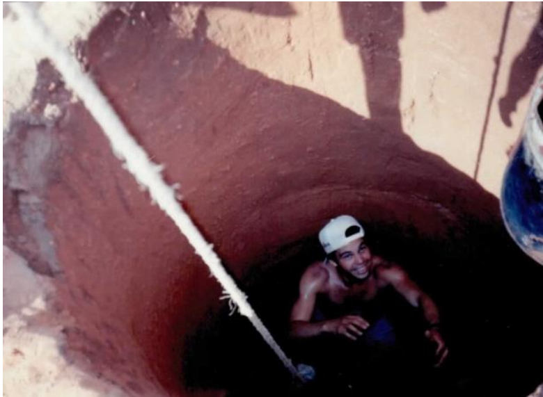
FIGURA 11- PERFURAÇÃO E EXECUÇÃO DO POCO ARTESIANO
