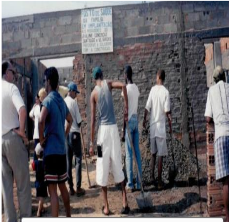
FIGURA 14 - CONSTRUÇÃO PELA COMUNIDADE DA “CASA DO MÉDICO”
