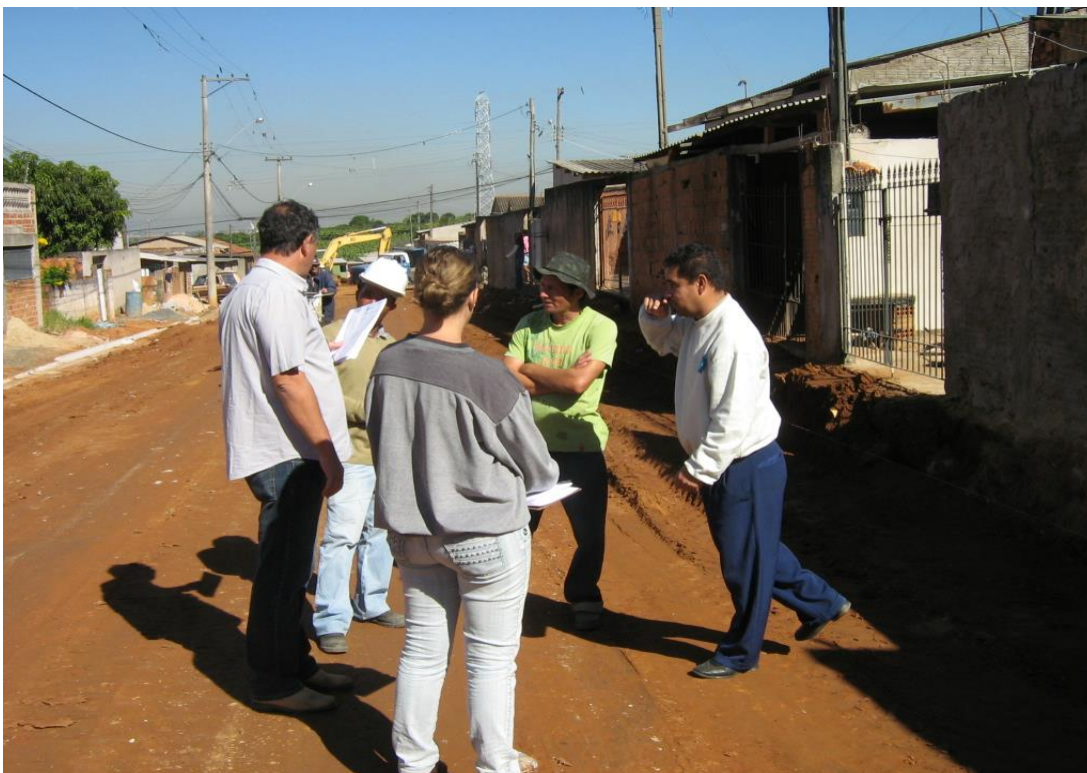
FIGURA 31- INÍCIO DAS OBRAS DE URBANIZAÇÃO
