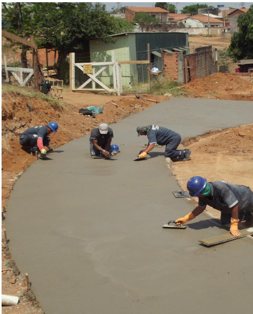
FIGURA 41- OBRAS DE URBANIZAÇÃO
