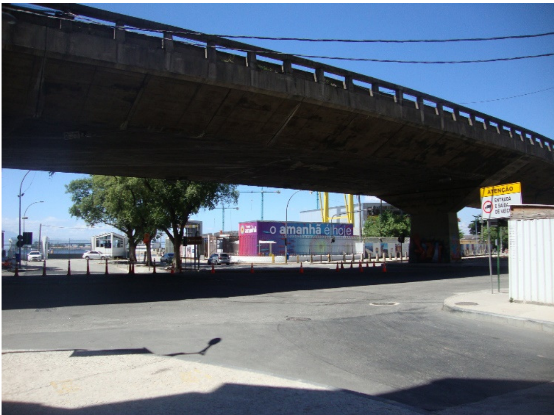
Imagem 1.23 – Avenida Perimetral e obras do Museu do Amanhã vistas a partir do chão.
