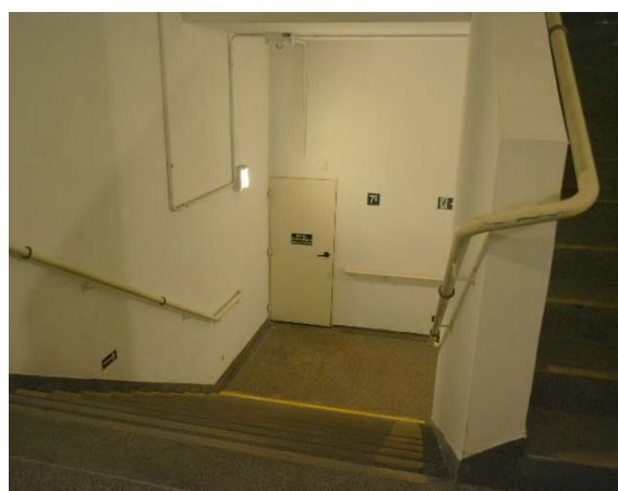
Figura 109: Corrimão na escada de emergência da nova torre
