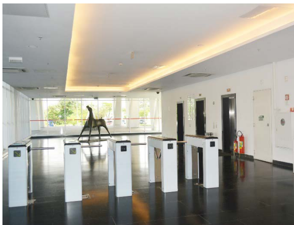
Figura 144: Catracas para controle de acesso instalado no Térreo.
