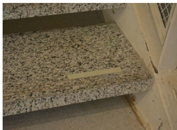
Figura 112: Sinalização de piso na escada do anexo de exposições
