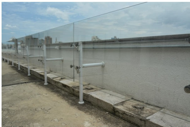
Figura 124: Nova barreira de segurança instalada no terraço da cobertura
