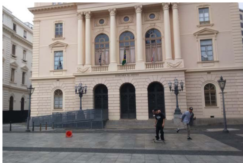
Figura 15: Rampa de acesso instalada na fachada principal do edifício da Secretaria da Justiça do Governo do Estado de São Paulo
