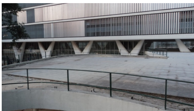
Figura 126: Terraço do Mezanino antes da instalação da barreira de segurança
