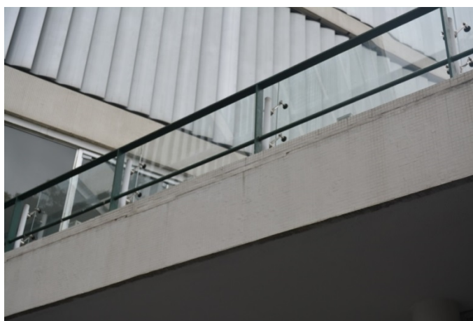
Figura 128: Vista do guarda-corpo original e do novo, no terraço do Mezanino.
