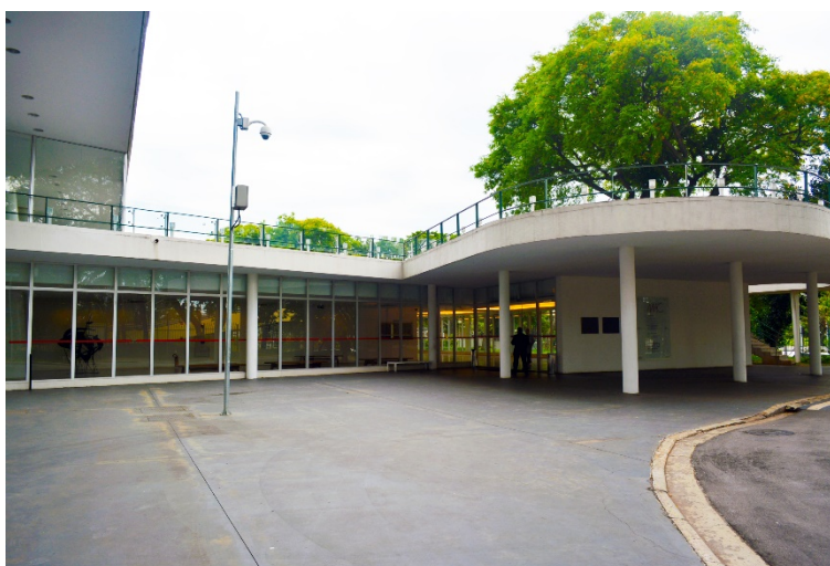
Figura 77: Rota acessível até o acesso principal ao edifício, por calçada com piso regular
