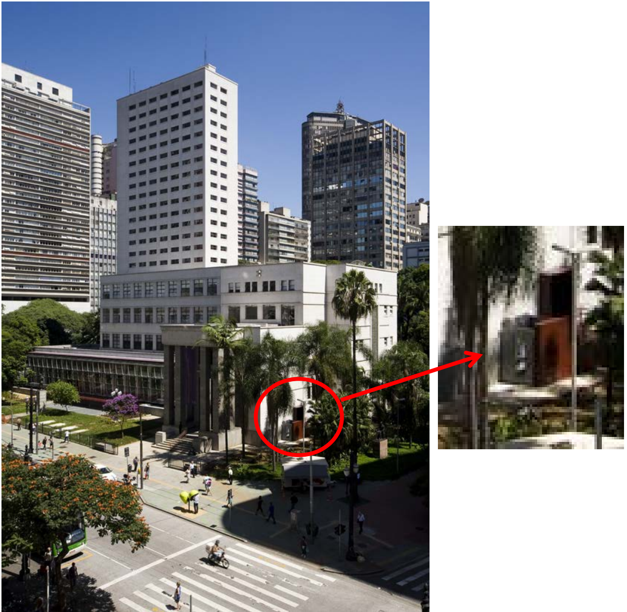
Figura 23: Vista da Biblioteca Mário de Andrade – Detalhe da plataforma elevatória
