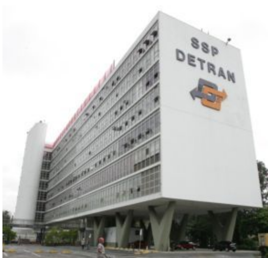
Figura 80: Fachada do edifício, na época da ocupação pelo DETRAN
