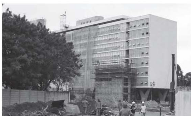
.Figura 89: Vista da fachada posterior do edifício, quando da construção de uma das novas torres contendo escada de emergência e elevador
