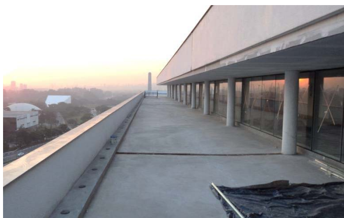
Figura 123: Área da cobertura durante o processo de restauro e antes da instalação da barreira de segurança
