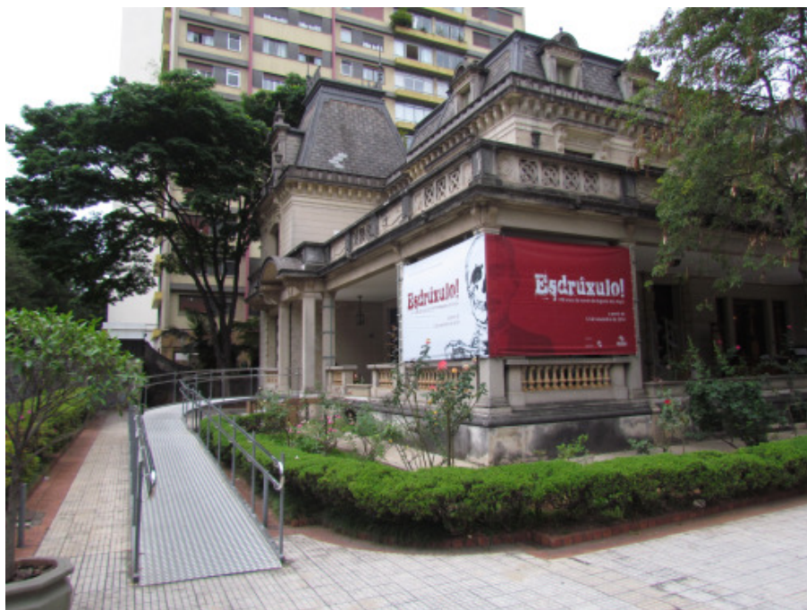
Figura 11: Rampa de acesso na entrada secundária da Casa das Rosas, sobreposta à estrutura da escada existente
