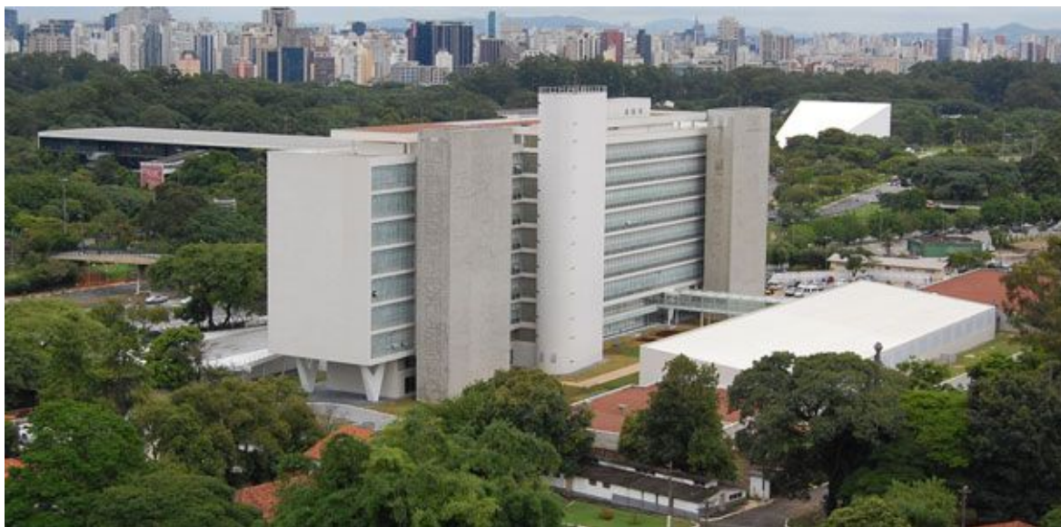
Figura 94: Vista posterior do edifício com novas torres construídas
