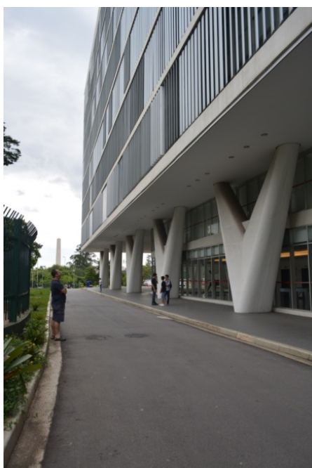
Figura 76: Rota acessível passando pela lateral do edifício, por calçada com piso regular
