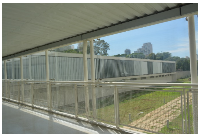
Figura 87: Brises verticais instalados no anexo
