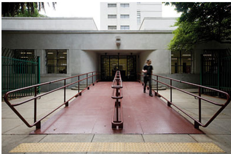
Figura 25: Rampa instalada no acesso da Av. São Luís – Biblioteca Mário de Andrade
