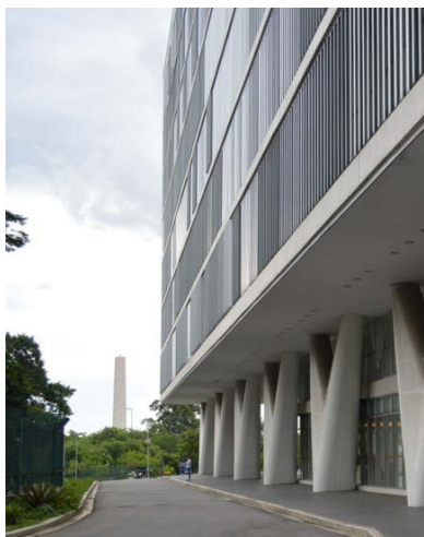
Figura 86: Brises verticais instalados na fachada oeste do prédio principal
