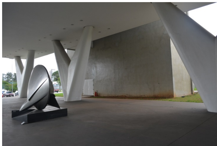
Figura 75: Rota acessível desde o estacionamento com piso regular
