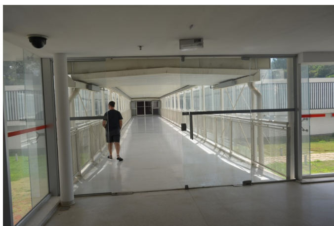
Figura 120: Vista interior da passarela de ligação entre edifício principal e anexo de exposições
