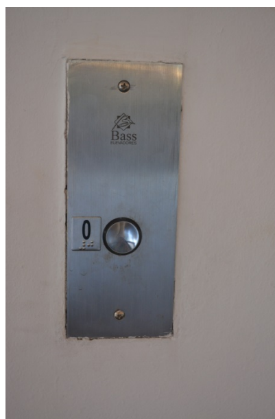
Figura 101: Painel externo do elevador com sinalização indicativa do pavimento atendido em Braille
