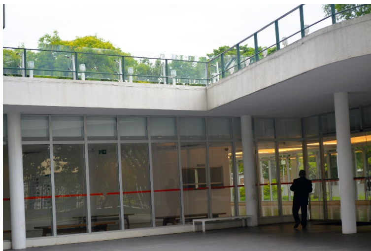
Figura 127: Vista do terraço do Mezanino a partir da área externa de acesso ao edifício, após a instalação do novo guarda-corpo.
