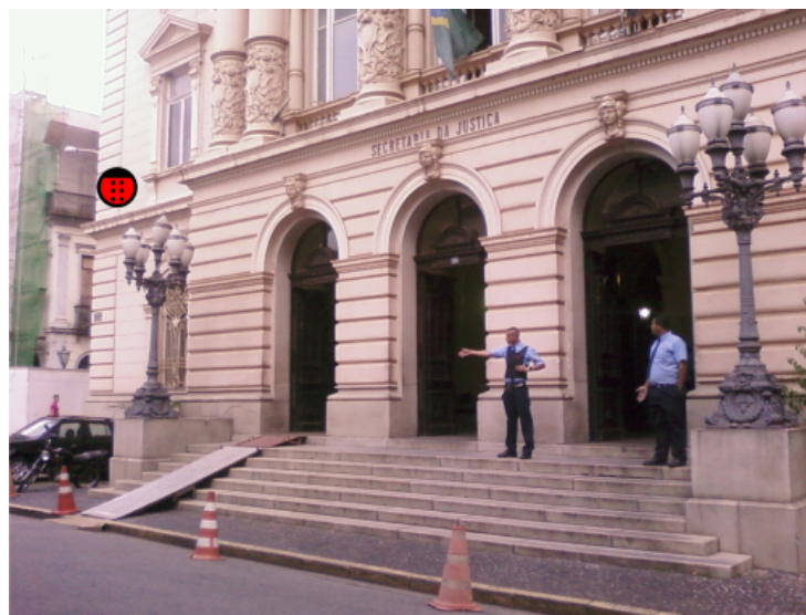
Figura 13: Rampa provisória colocada sobre os degraus da escada de acesso a Secretaria da Justiça do Governo do Estado de São Paulo
