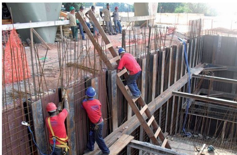
Figura 92: Execução da fundação de uma das novas torres
