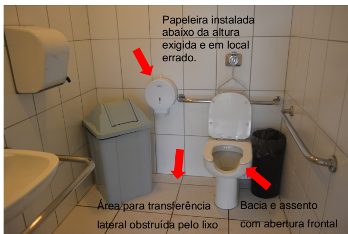
Figura 136: Vista interna banheiro masculino acessível
