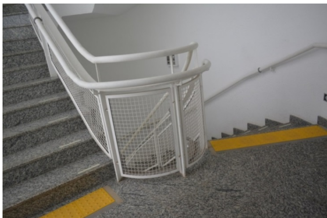
Figura 107: Escada existente na torre central, evidenciando-se o acréscimo no guarda-corpo.
