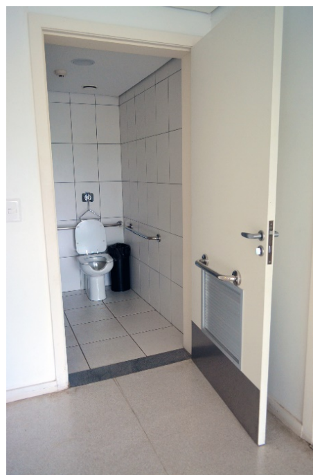
Figura 134: Vista interna da porta do banheiro masculino acessível
