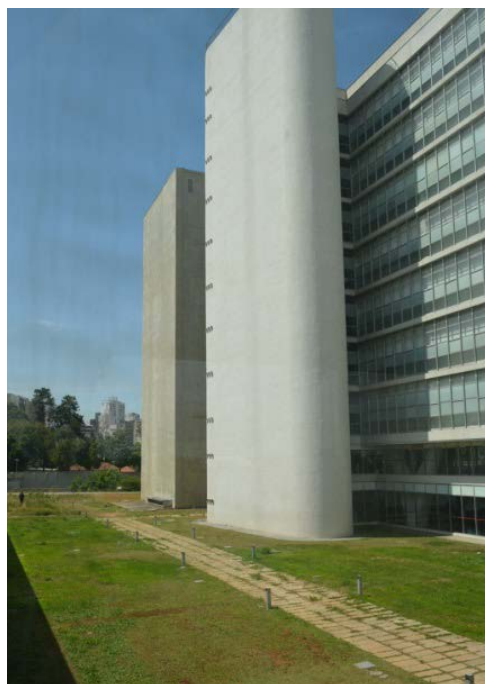
Figura 91: Vista da fachada posterior com as novas torres construídas
