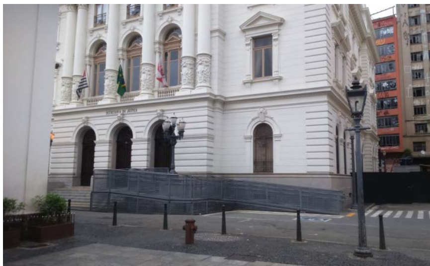
Figura 14: Rampa de acesso instalada na fachada principal do edifício da Secretaria da Justiça do Governo do Estado de São Paulo
