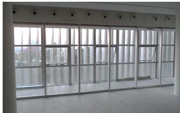
Figura 85: Área de um dos pavimentos tipo durante obra, local a ser instalado corredor técnico
