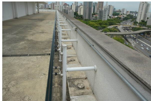
Figura 125: Vista lateral da nova barreira de segurança instalada no terraço da cobertura
