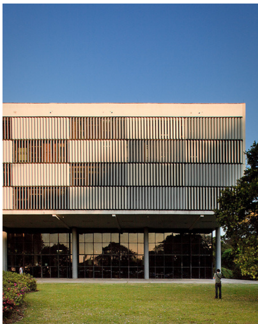
Figura 88: Brises verticais instalados no prédio da Bienal no Parque do Ibirapuera
