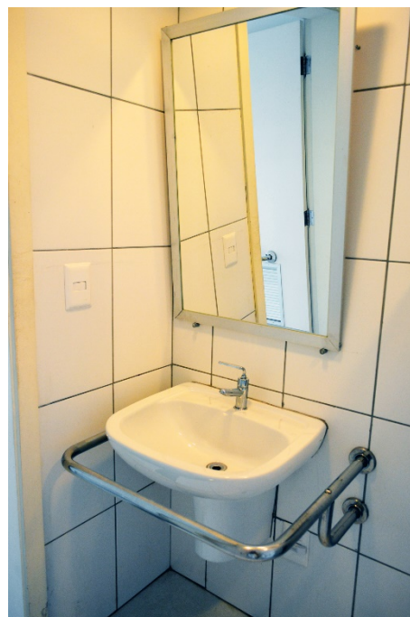
Figura 137: Vista da pia do banheiro masculino acessível
