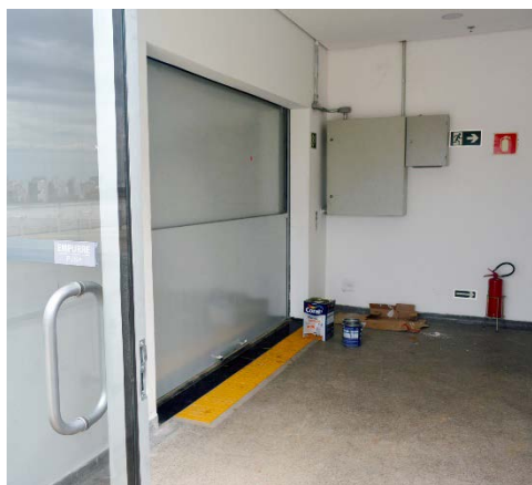
Figura 97: Elevador de carga na nova torre
