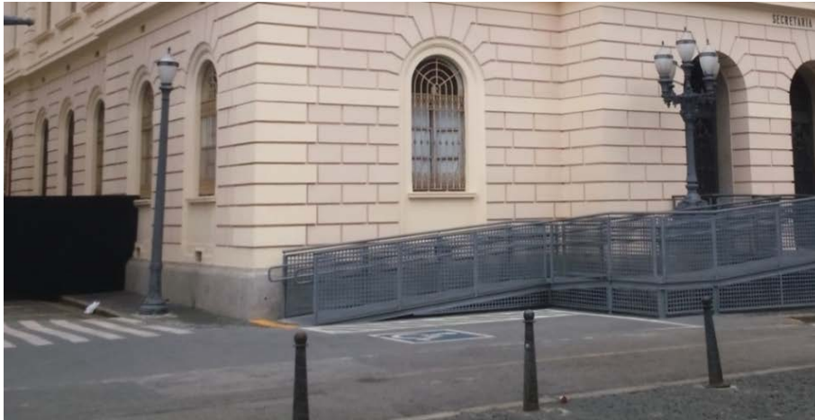
Figura 16: Rampa de acesso na entrada principal da Secretaria da Justiça do Governo do Estado de São Paulo
