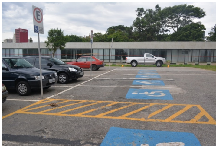
Figura 73: Vagas acessíveis localizadas no estacionamento aberto ao público
