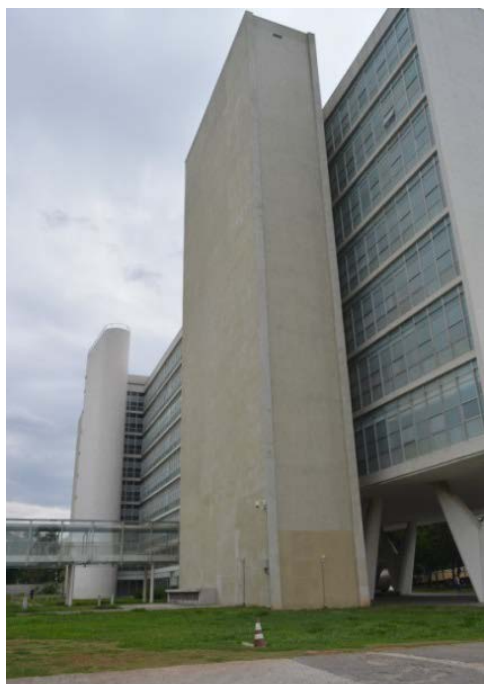
Figura 90: Vista da fachada posterior com as novas torres construídas
