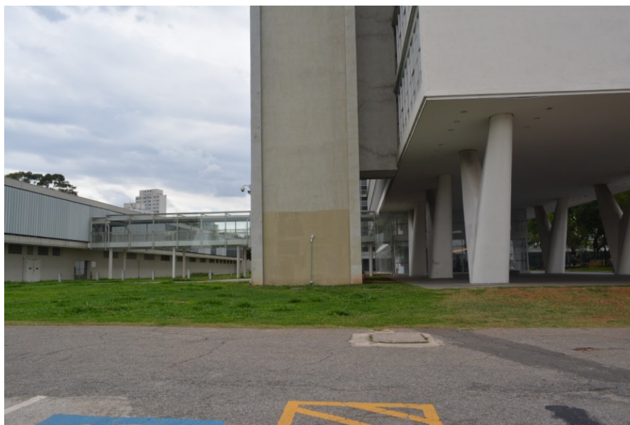
Figura 93: Vista lateral evidenciando o afastamento entre a nova torre construída e o prédio principal
