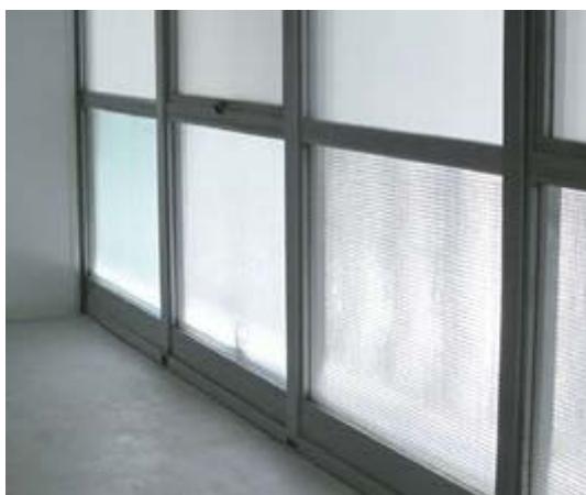
Figura 82: Diferença na tonalidade evidencia vidros originais dos novos
