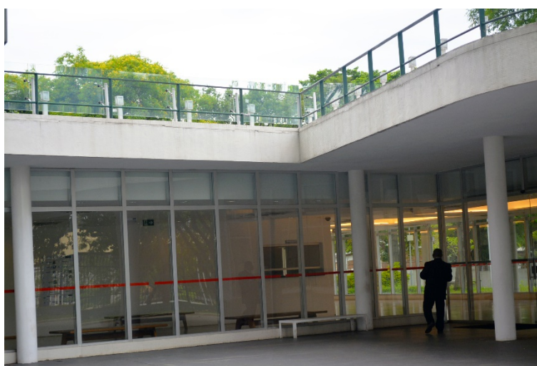
Figura 79: Acesso à edificação – Térreo
