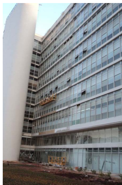
Figura 83: Intervenção na fachada posterior para recuperação dos caixilhos e troca dos vidros necessários
