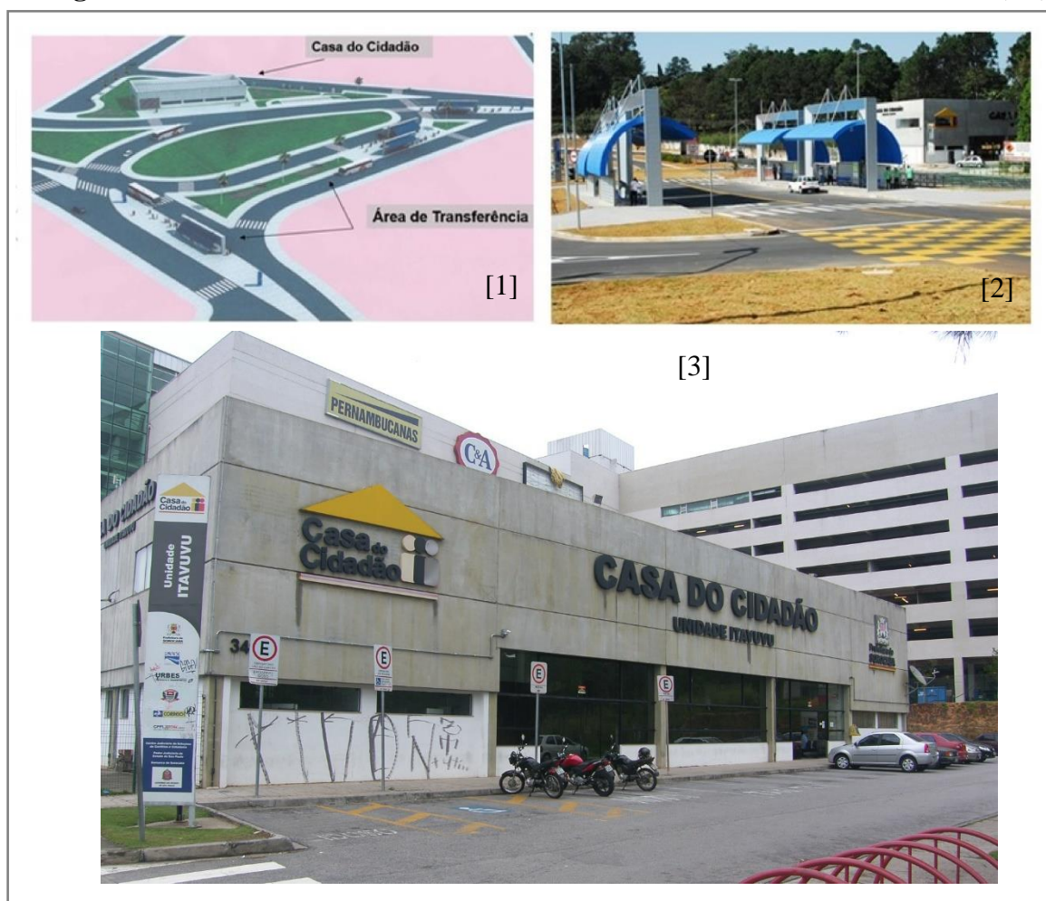
Figura 25. Casa do Cidadão e Terminais Urbanos Interbairros em Sorocaba (SP)
