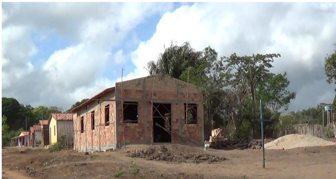
Figura 7 - Nova capela de Nossa Senhora das Graças (em construção).Foto do arquivo pessoal da pesquisadora, 2015
