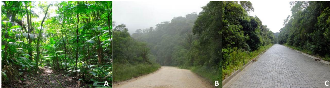
Figura 2. Vias em meio ao Parque Estadual “Carlos Botelho”, Estado de São Paulo, sudeste do Brasil. A. Trilha destinada ao ecoturismo, trecho Represa-Fornos; B. Estrada Parque Serra da Macaca anterior à pavimentação; C. Estrada Parque Serra da Macaca após a pavimentação.
