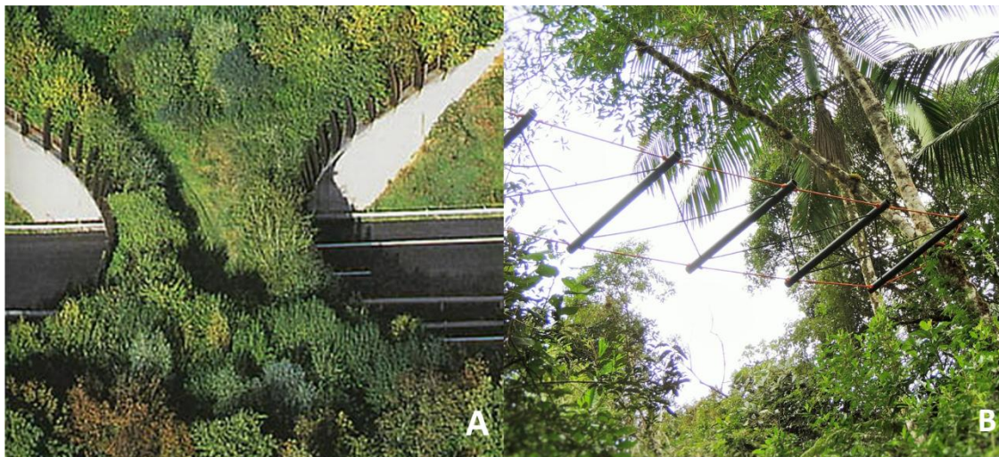
Figura 3. Medidas mitigadoras para conexão da vida selvagem em paisagem fragmentada por estradas. A. Viaduto vegetado construído para passagem da vida selvagem em Montana, USA. B. Ponte de cordas para passagem de fauna, Estrada Parque Serra da Macaca, Parque Estadual Carlos Botelho, Brasil.
