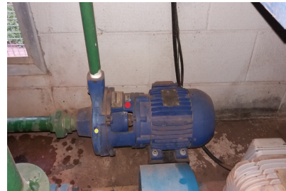
(b) bomba centrífuga de alimentação;
