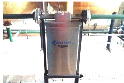
(c) medidor de fluxo mássico;
