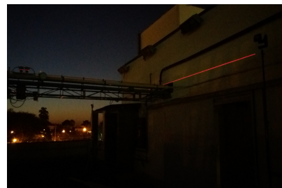
(d) alinhamento externo, próximo à estação 4;
