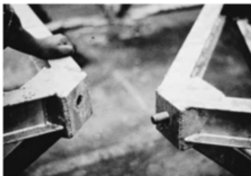
Figura 41: Unibat, um dos sistemas de conexão propostos por Du Château, na França.
