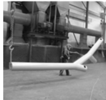
b. Serviços de pré-montagem do elemento (pintura).
