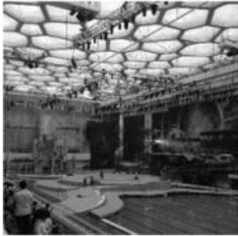
a. Polígonos no teto do ambiente da piscina olímpica, obtidos por meio da seção plana da estrutura.
