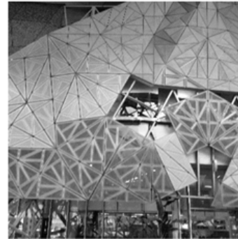
b. Painéis separando alguns conjuntos de triângulos por cores e com alguns triângulos suprimidos do conjunto.
