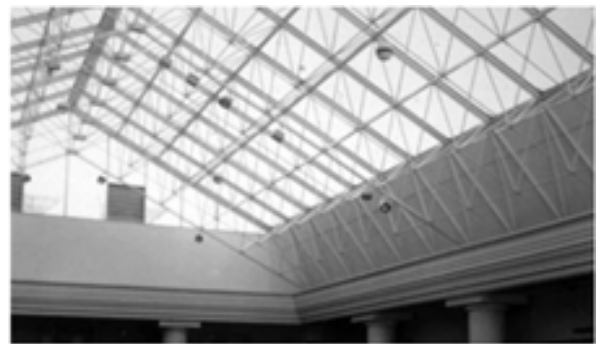
b. Space deck, amplamente utilizado em estruturas de cobertura. Fonte: http://www.tatasteelconstruction.com
