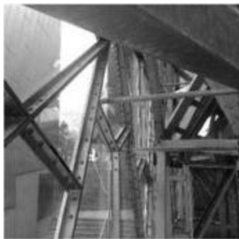
a. Conexões da estrutura periférica externa.
