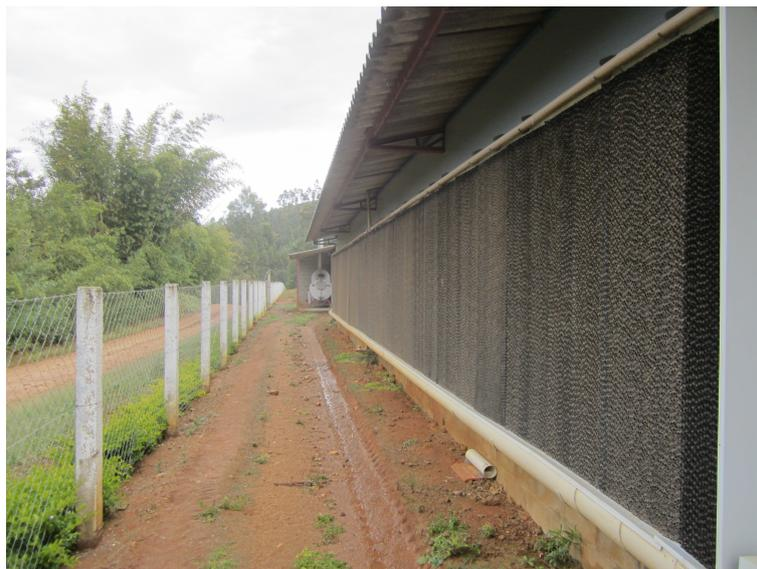
Figura 2.10: Painel evaporativo de um aviário tipo túnel com pressão negativa.
