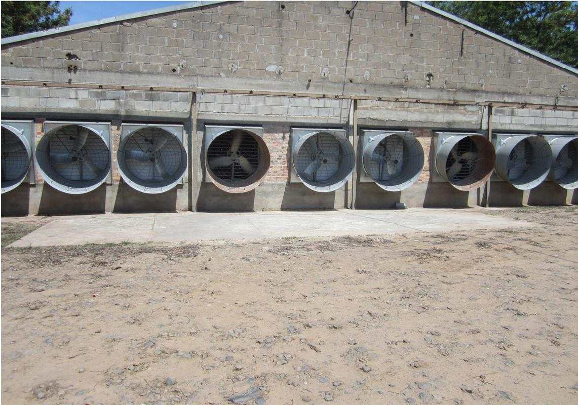
Figura 2.9: Exaustores de um aviário tipo túnel com pressão negativa.
