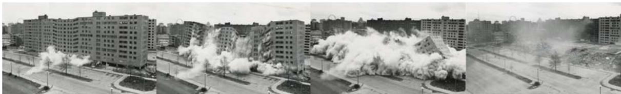
Figura 96. Demolição do conjunto habitacional Pruitt-Igoe.
