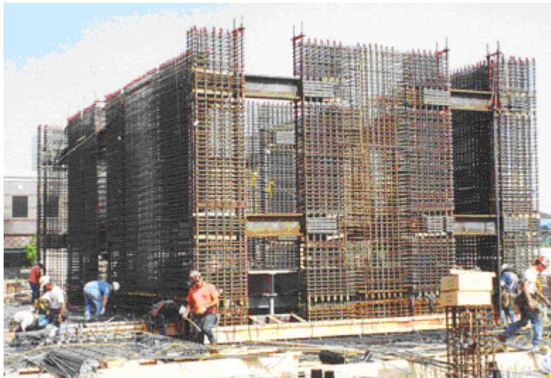
**Figura 16 – Construção de paredes de cisalhamento mistas com colunas revestidas e vigas de aço (EL-TAWIL, 2008)**
