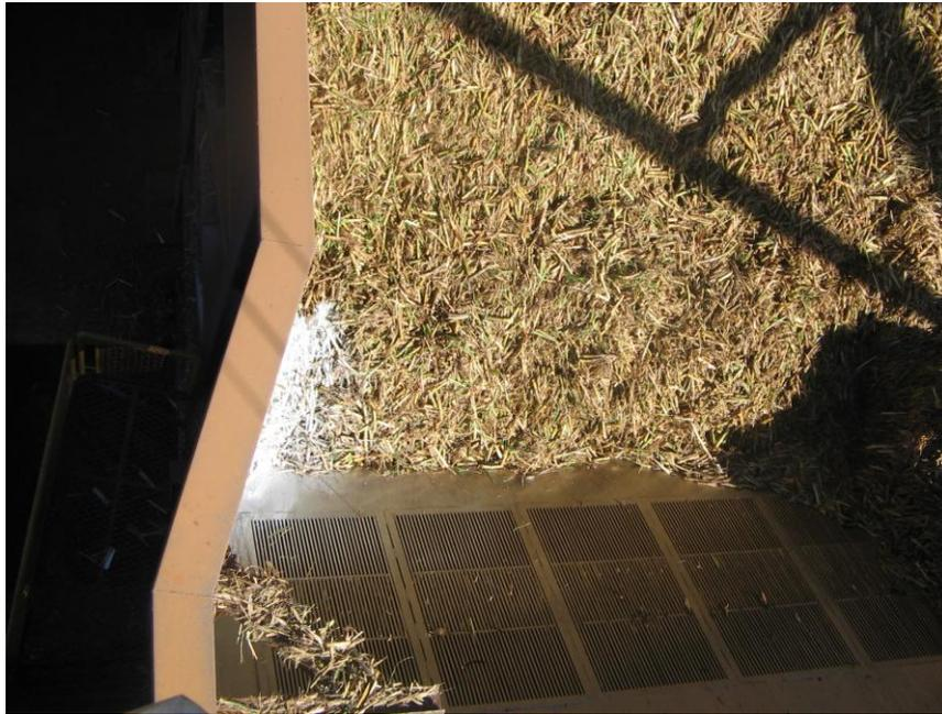
**Figura 15:** Grelha da mesa alimentadora – Usina Cerradinho.
