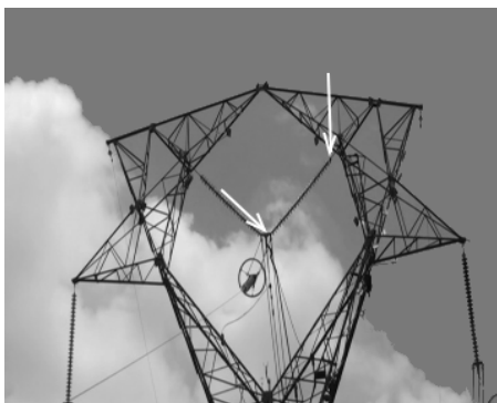
Figura 7.2: Detalhe de uma torre de alta tensão destacando as extremidades da cadeia de isoladores.
