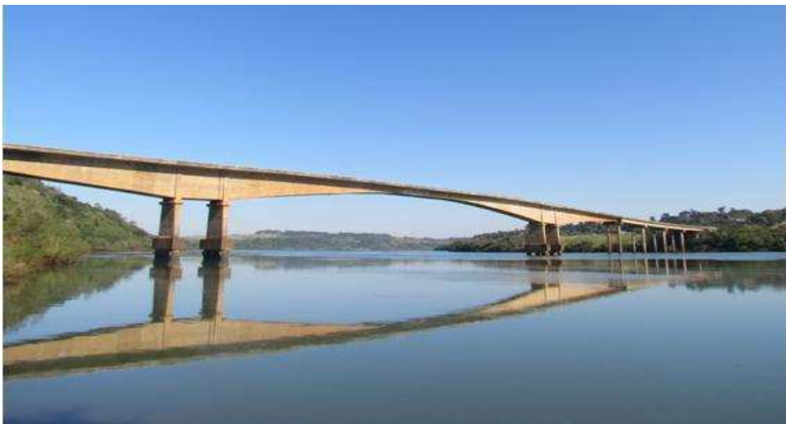
Figura E.2: Ponte sobre o Rio Iguaçu da Rodovia PR-182, facilita a ligação entre Capitão Leônidas Marquez e Realeza no estado do Paraná.
