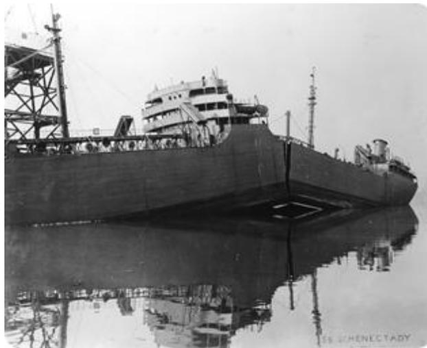
Figura 1.1: Exemplar do navio Liberty após falha estrutural
