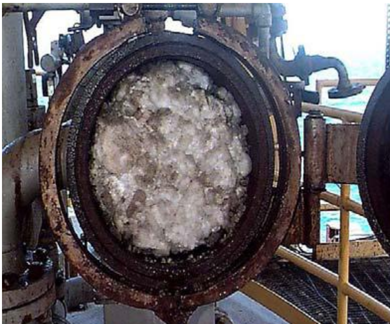
Figura 2.12: Hidratos no interior da linha.
