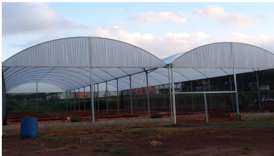
Figura 4.16: Vista geral da estufa de plantio.
