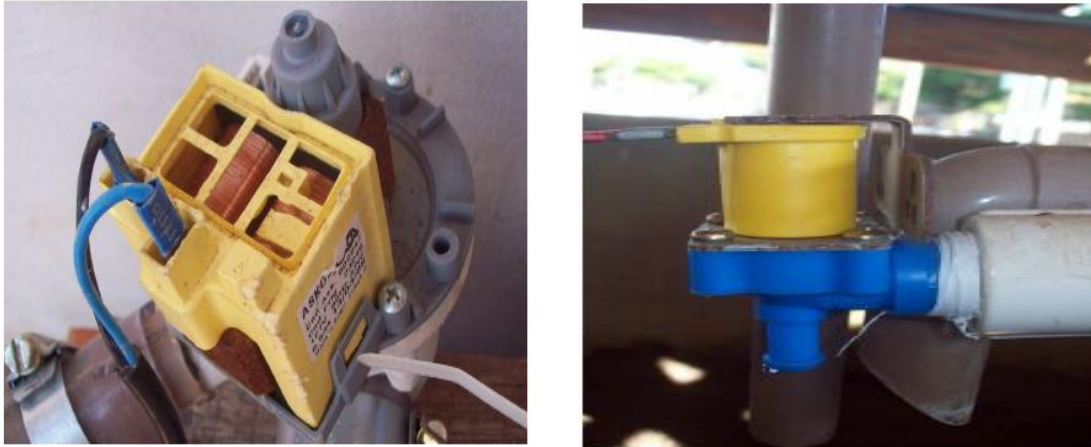
Figura 4.14: Detalhe da bomba utilizada para o envio do efluente aos filtros de areia e a válvula de aplicação do sal.
