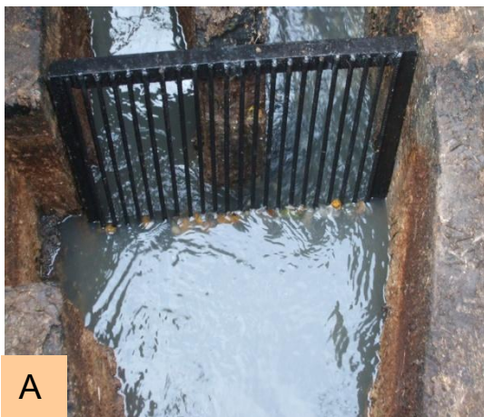
Figura 4.3: Vista do sistema de gradeamento (A) e local da instalação da bomba de captação (B).
