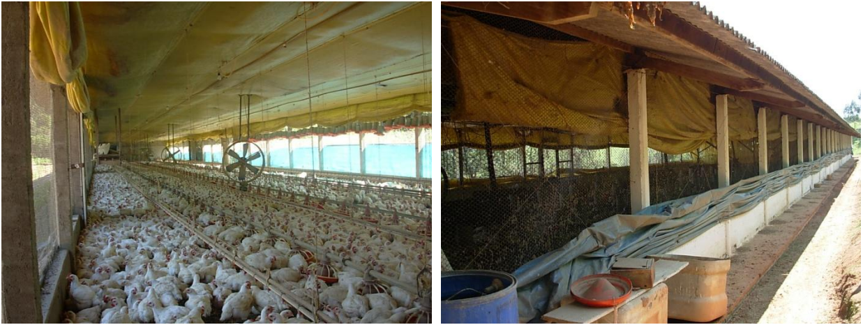
Figura 5 Galpão com ventilação tipo túnel com pressão positiva, chamado de “galpão A2”.
