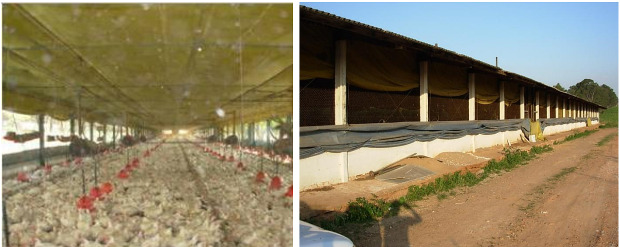
Figura 4 Galpão com ventilação tipo túnel com pressão positiva, chamado de “galpão A1”.
