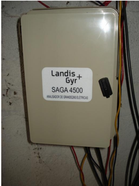
Figura 23 Analisador e registrador eletrônico de sistemas elétricos monofásicos ou trifásicos SAGA4500 AMPFLEX
