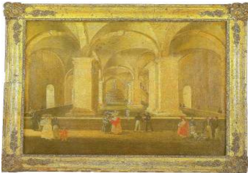
FIGURA 10 Reservatório das Amoreiras
