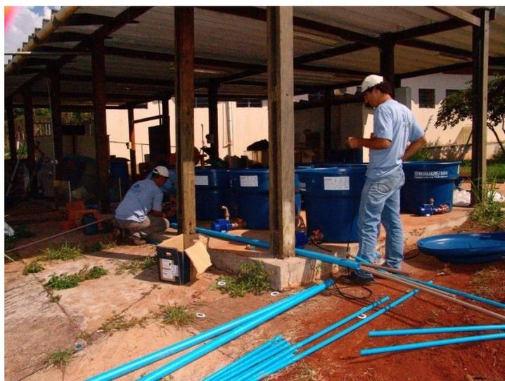
**Figura 7 - Vista dos reservatórios com suas respectivas bombas, na área de pesquisa de reúso de efluentes sanitários**
