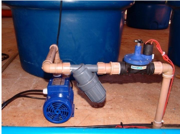
**Figura 8 - Detalhe da bomba, filtro e válvula solenóide do sistema de gotejamento**
